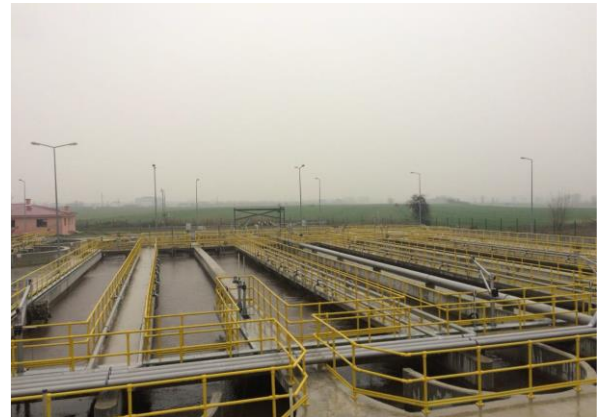
Muratlı İleri Biyolojik Atıksu Arıtma Tesisi
