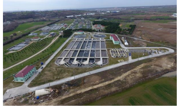
Çerkezköy-Kapaklı İleri Biyolojik Atıksu Arıtma Tesisi
