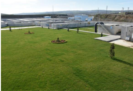
Süleymanpaşa Batı İleri Biyolojik Atıksu Arıtma Tesisi
