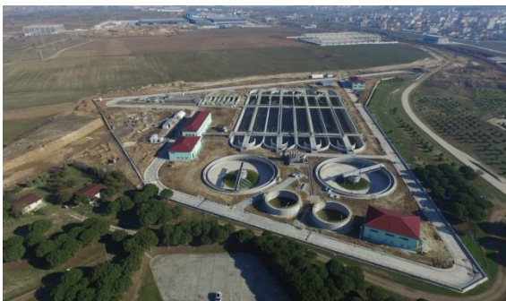
Çorlu İleri Biyolojik Atıksu Arıtma Tesisi (Anonim 2018e)
